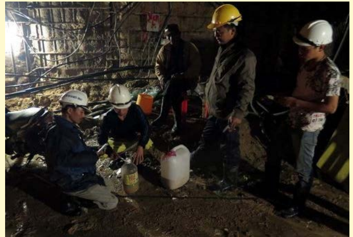
Vụ sập hầm thủy điện Đạ Dâng-Đạ Chomo năm 2014. Công tác cứu hộ trong điều kiện thiếu sáng gặp nhiều khó khăn. Nguồn: Thanhnien.vn
